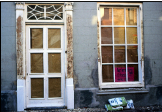
Om de verhoogde voordeur op straatniveau te brengen wordt een extra hoge deur aangebracht. De ramen worden aan de onderkant uitgebreid met drie ruitjes.
