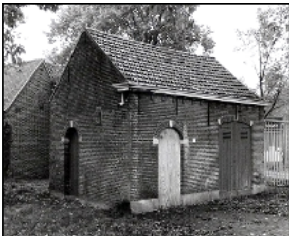
Het spuihuisje in Dorst, vóór de restauratie.
