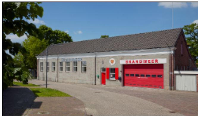
Het spuihuisje hoort bij de brandweerkazerne aan het Kapelerf 2 in Dorst.
