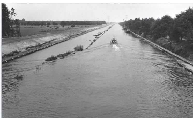
Het Markkanaal werd aan de noordkant (links op de foto) verbreed en verdiept. In het kanaal is nog net de oude oever te zien; het kanaal wordt bijna twee keer zo breed. Rechts de dijk met de nieuwe boordvoorziening die werd aangelegd met behulp van schroefankers. (Foto ministerie van Verkeer en Waterstaat)
