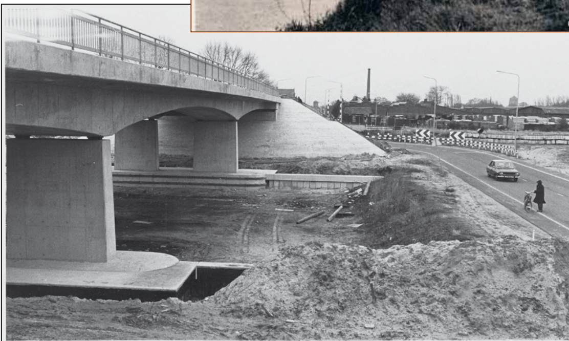
◀ De huidige brug aan de Bredaseweg in aanbouw met rechts de tijdelijke omloop ten behoeve van de emballagefabriek Simfa.
