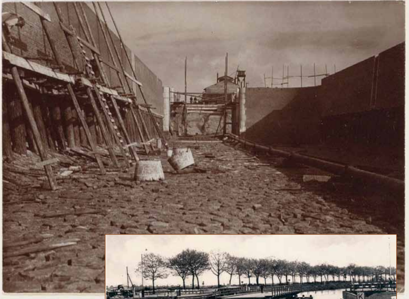
Aanleg van de sluisbedding ▲
