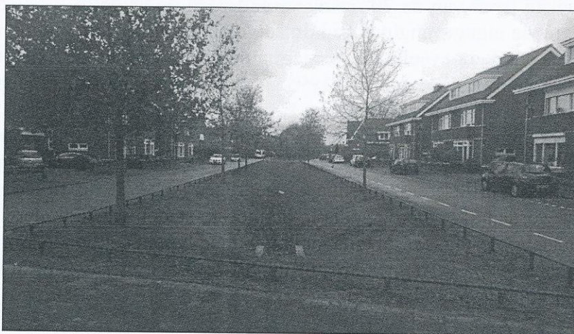
In de 21 e eeuw ligt het Oosterhoutse waterbeheer in de stad grotendeels nauwelijks zichtbaar in riolen ondergronds
