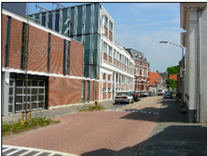
Appartementencomplex Het Kolombijn. Aan de ramen is nog te zien hoe de indeling vroeger was.
