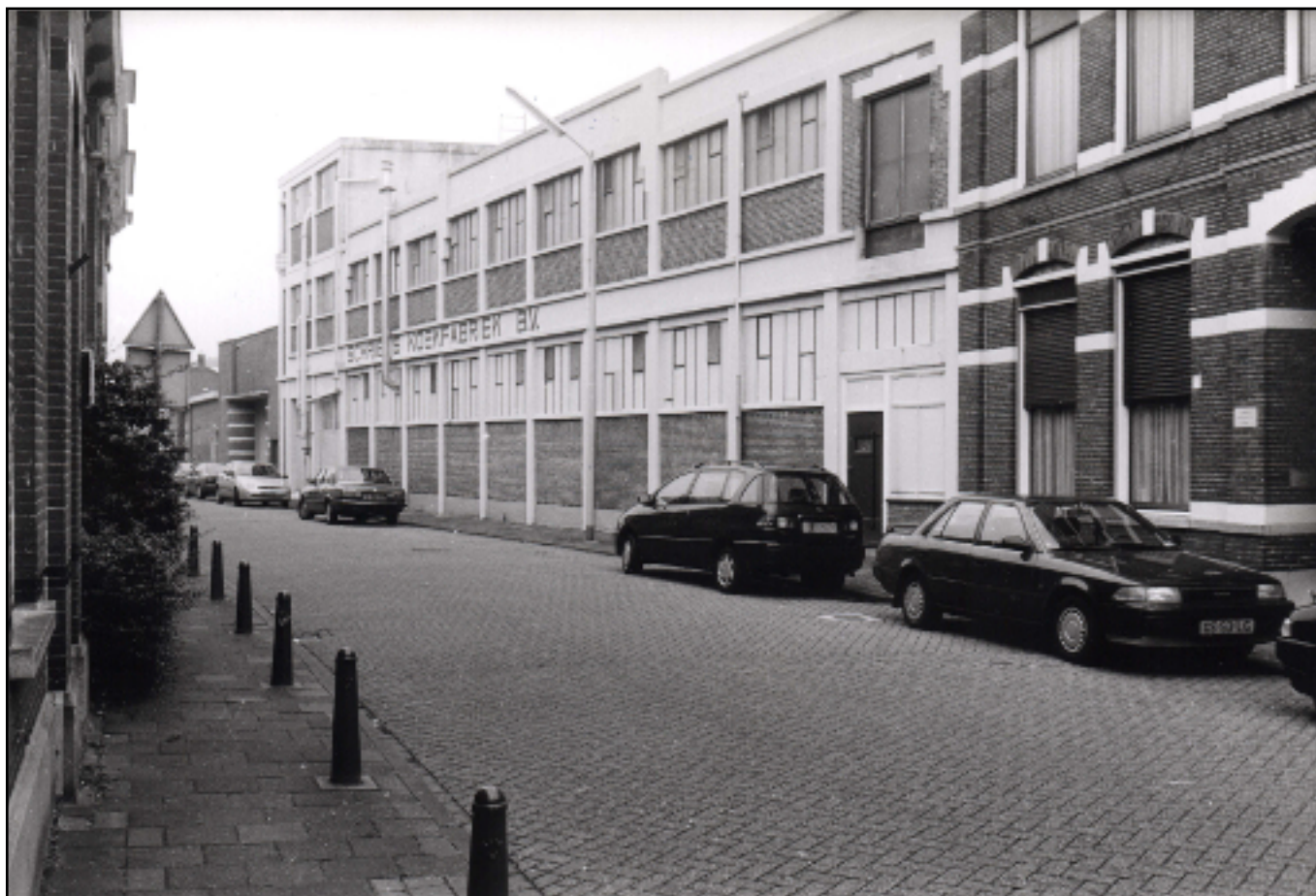
De koekfabriek vóór de renovatie, waarbij het oude gebouw omgetoverd wordt in een appartementencomplex met de naam Het Kolombijn.
