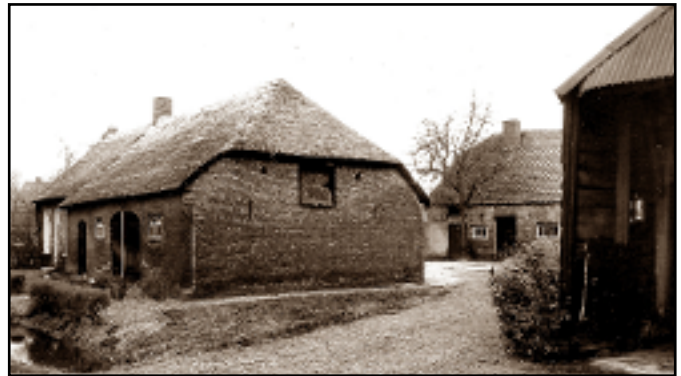
Zicht op de 'werft' van de boerderij die vroeger aan Leijzenstraat 5 stond. De opname dateert uit 1979.
